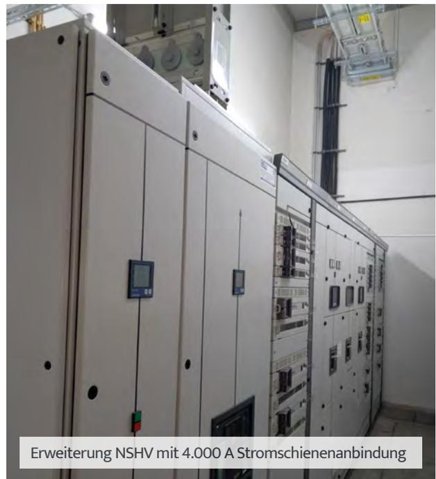
Erweiterung NSHV mit 4.000 A Stromschienenanbindung
