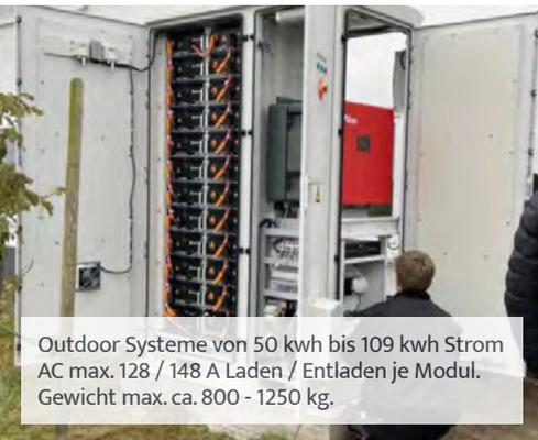
Outdoor Systeme von 50 kwh bis 109 kwh Strom
