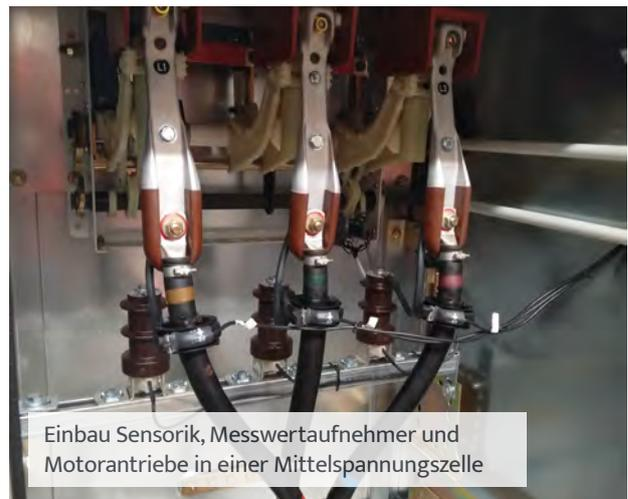
Einbau Sensorik, Messwertnehmer und Motorantriebe in einer Mittelspannungszelle
