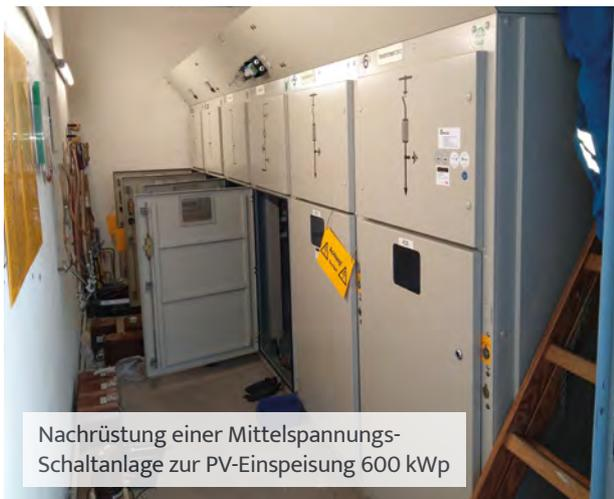
Nachrüstung einer Mittelspannungsschaltanlage zur PV-Einspeisung 600 kWp
