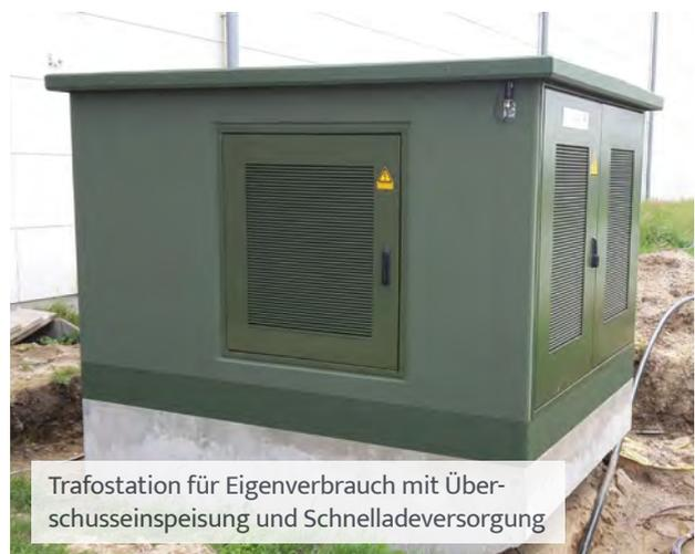
Trafostation für Eigenverbrauch mit Überschusseinspeisung und Schnelladeversorgung
